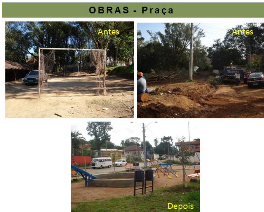
Figura 10 - Fotos da implantação da Praça concluída em 2015
