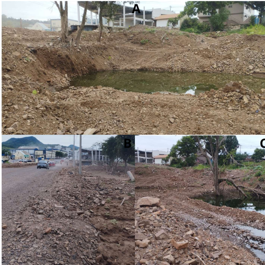
Figura 9 - Danos estruturais na canalização do Arroio Sete de Setembro e na Av. General Daltro Filho (ponto 4).
