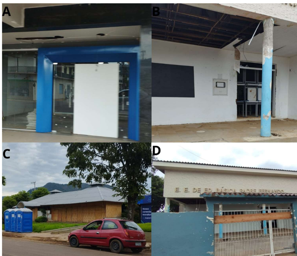
Figura 11 - Fachadas de equipamentos comerciais e educacionais (pontos 7 e 8)
