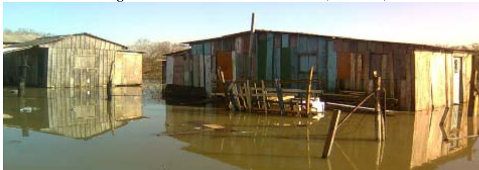
Figura 10 – Enchente na Rua Porto Rico, Alvorada, 2009.
