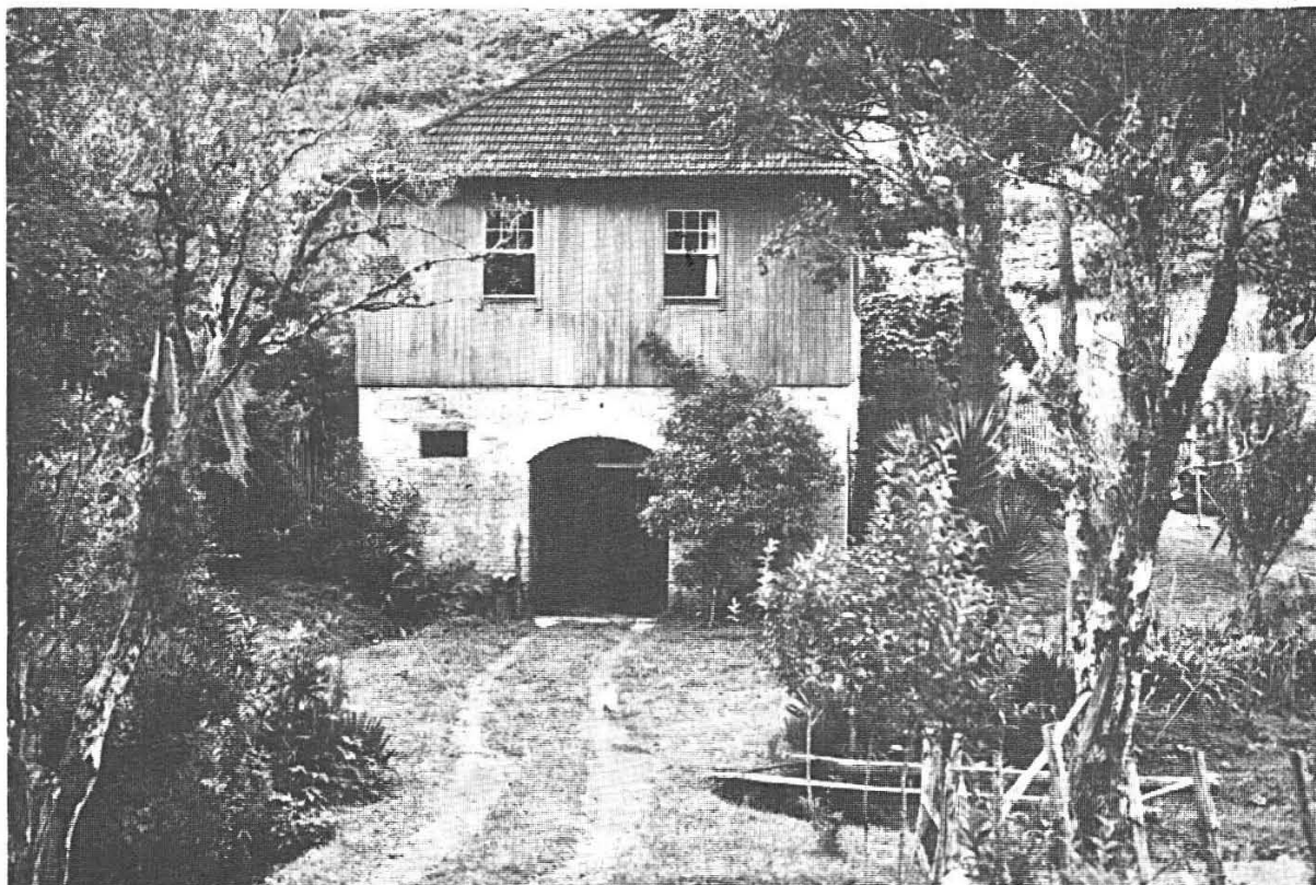
Casa na zona vitivinicola da antiga área colonial italiana, com cantina construída de tijolos e a parte superior de madeira. (foto P. L. Beretta)
