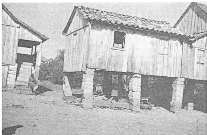
As moradias e instalações nas margens do baixo Taquari são construídas sobre pilotis, como forma de proteção contra as cheias periódicas neste terraço fluvial.
