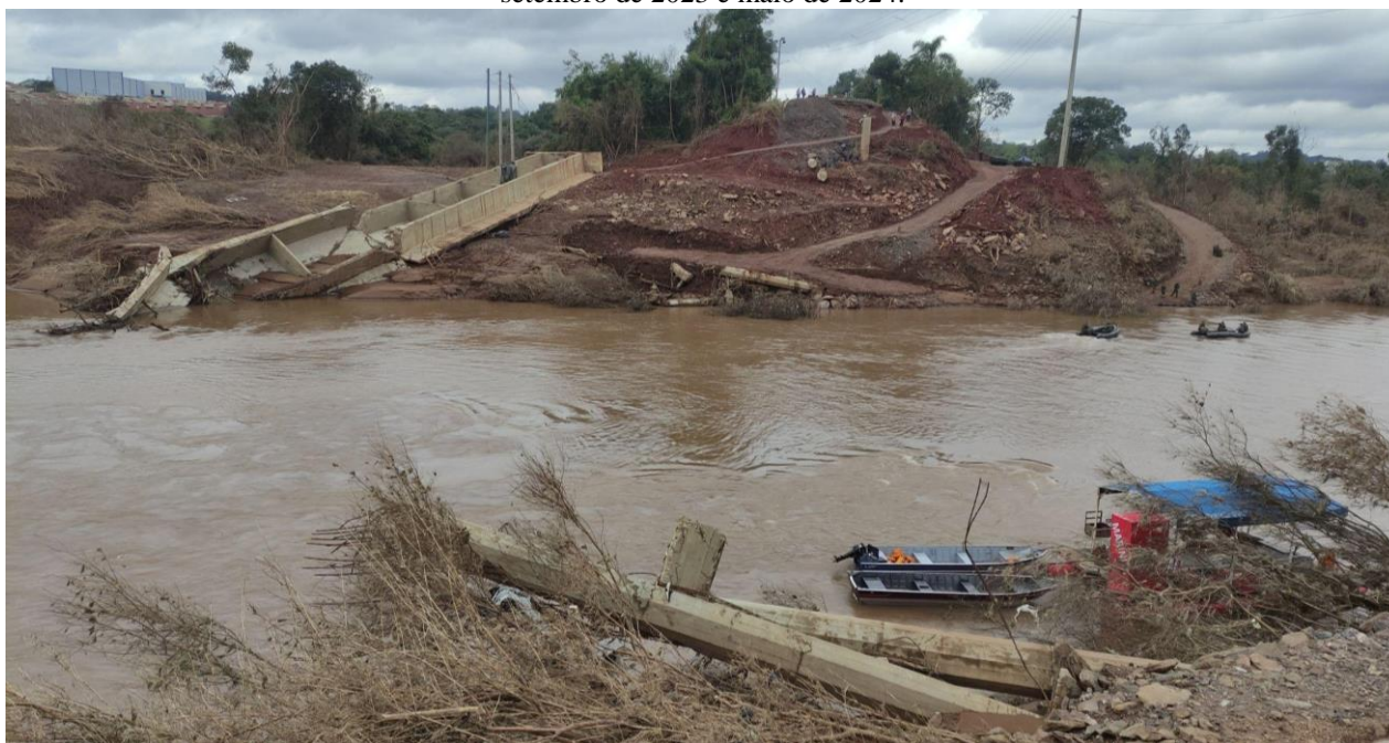
Figura 8 - Fisionomia da destruição total da ponte da RS 130 sobre o Rio Forqueta entre as cidades de Lajeado e Arroio do Meio. Houve a danificação e o colapso completo de dezenas de pontes na BHTA em função das inundações de setembro de 2023 e maio de 2024.
