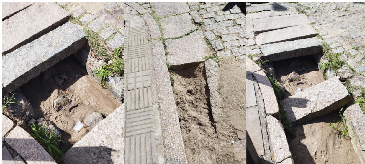
Figura 7 - Bocas de lobo obstruídas no centro do município de Jaguarão.
