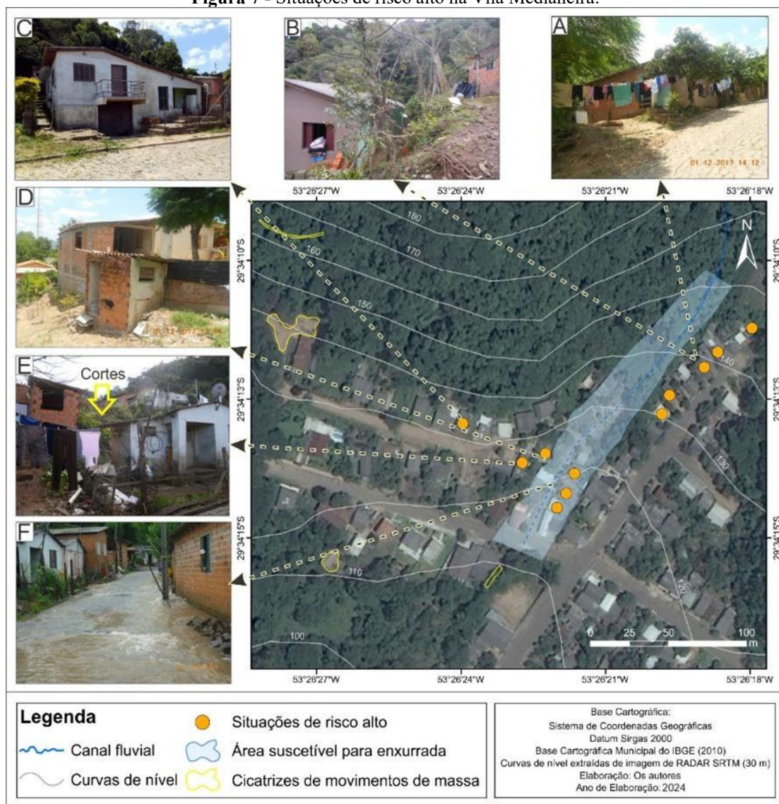
Figura 7 - Situações de risco alto na Vila Medianeira.
