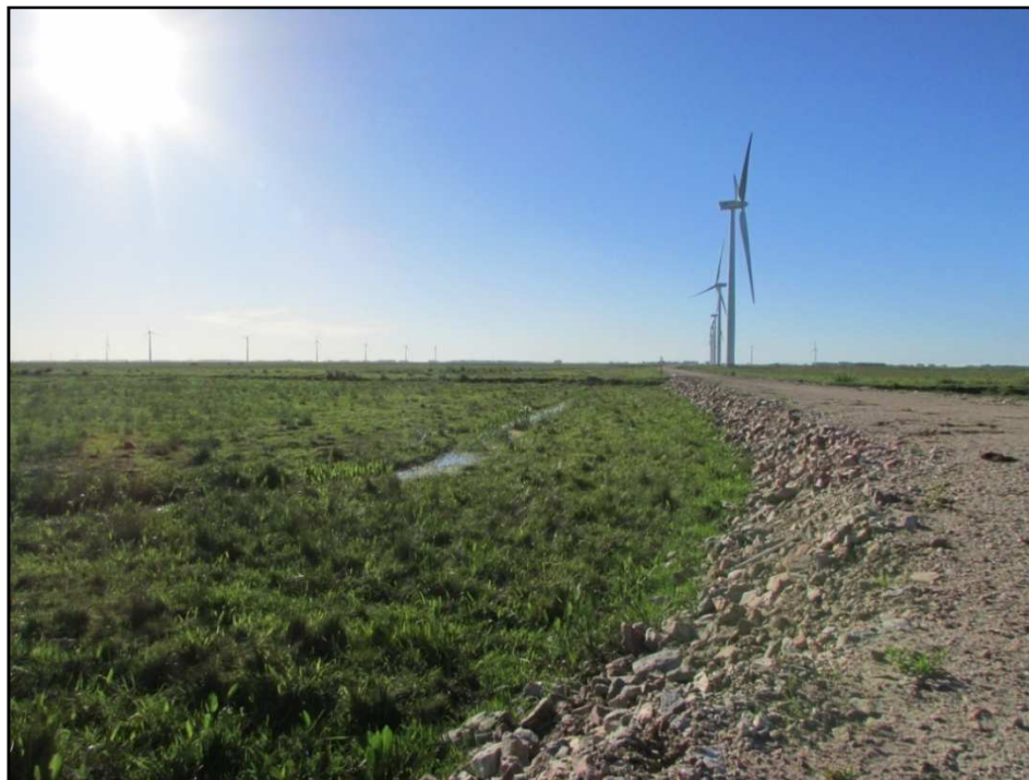
Figura 5 – Quantidade significativa de material (balastro) para estradas de acesso ao Parque Eólico é uma melhoria constatada.
