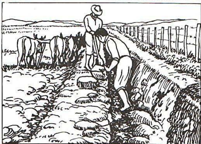
Des. 3. Construção de um canal de irrigação em torroes (Rio Pardo).
