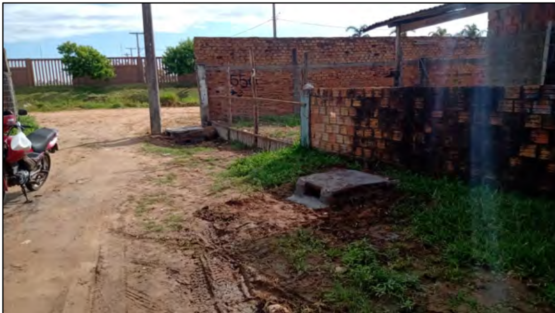
Figura 3 – Alternativa de drenagem superficial feita pelos moradores do bairro.
