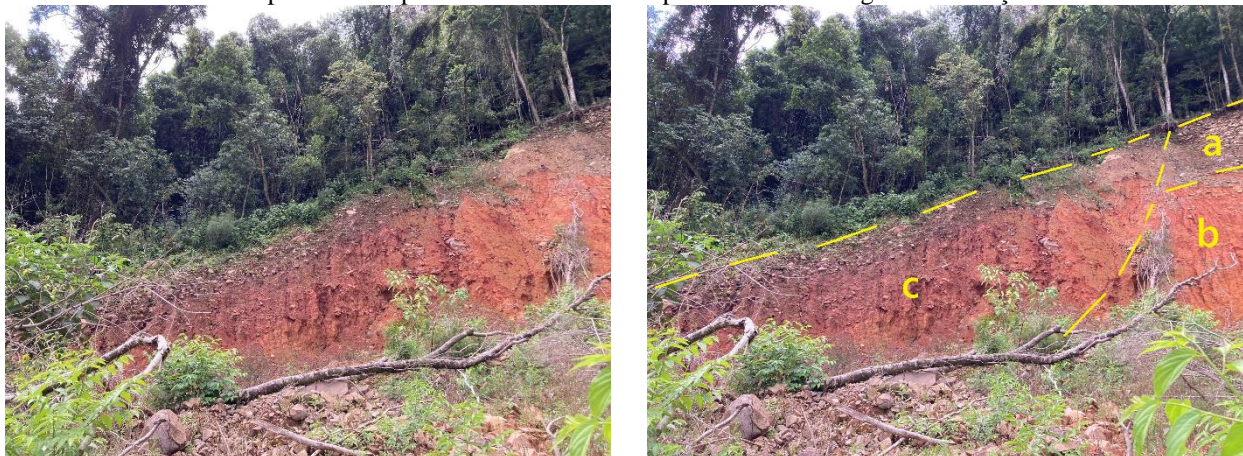
Figura 16 - Visão em detalhe ruptura vista na cicatriz de deslizamento em Bento Gonçalves da Fig. 11. (a) maciço rochoso de riodacito fraturado, (b) maciço rochoso de riodacito intemperizado e (c) colúvio-tálus produzido na evolução da encosta a partir do desprendimento dos blocos produzidos na margem do maciço fraturado
