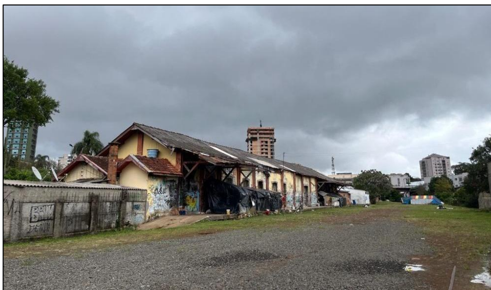
Figura 11 - Parte posterior da estação férrea de Erechim
