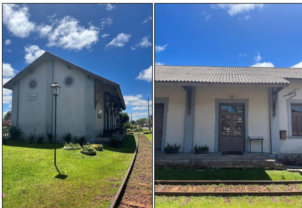
Figuras 8 e 9 - Estação ferroviária de Gaurama após reformas
