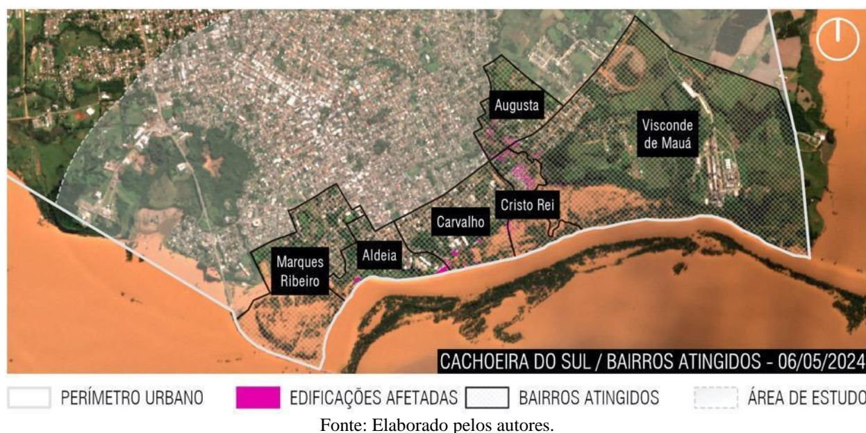
Figura 4 - Mapa das edificações impactadas pela inundação que ocorreu em maio de 2024 em Cachoeira do Sul.
